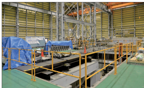
ピットを備えたプレス組み立て工場
