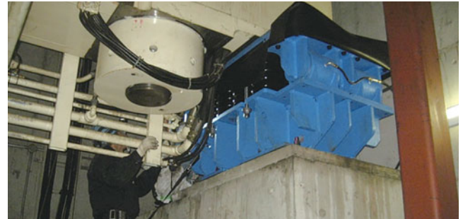
コイルばね式防振装置 据付風景
