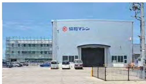
第二工場隣、建設中のテクニカルセンター
